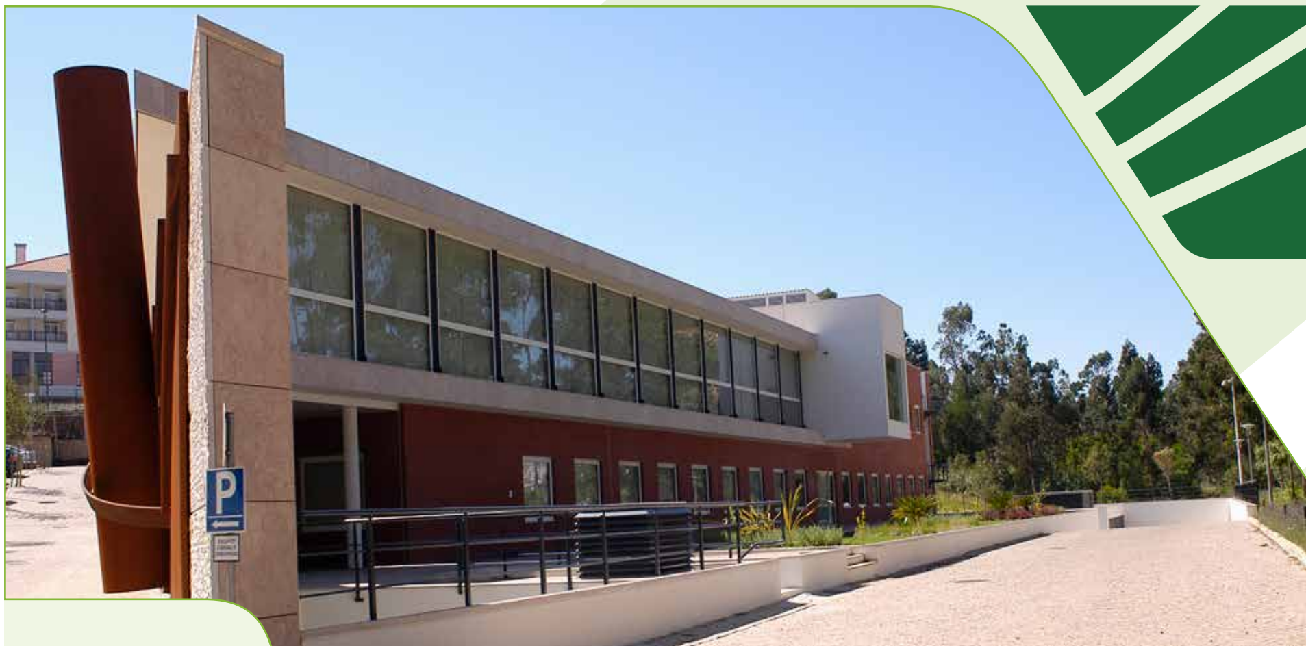
Instalações do LEF em Barcarena
